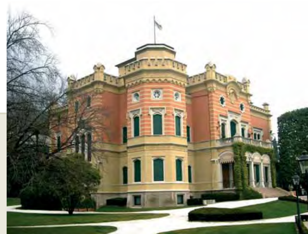
Nome: Grand Hotel Villa Feltrinelli, Gargnano del Garda, Brescia Prodotti utilizzati: Fondo minerale KEIM CONTACT-PLUS KEIM GRANITAL in velatura
